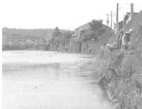
堀川町の町周辺の清掃作業
