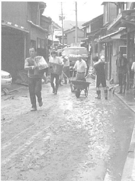
堀川間の町での復旧作業
