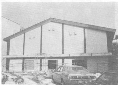
竣工近い新体育館
